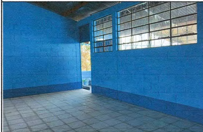
Foto 4: INSTALACION DE PISO DE GRANITO Y PINTURA
