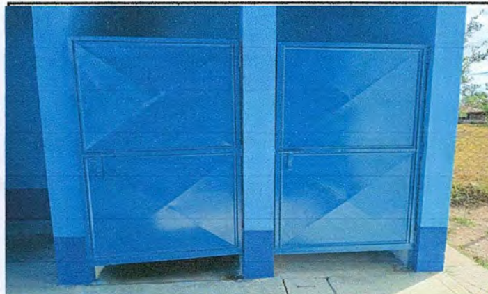
Foto 2: PUERTAS DE SANITARIOS
