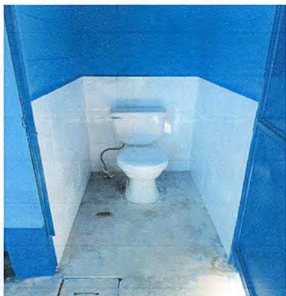
Foto 3: INTALACION DE SANITARIOS
